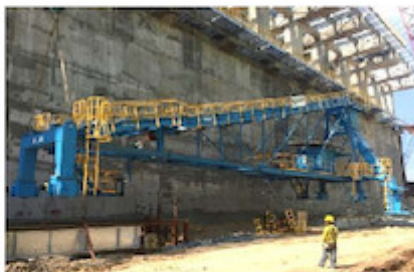
Foto 2: Der Abwurfsteg wurde komplett vormontiert und mit Hilfe von Kränen auf die Schienen gehoben. (Foto SCHADE)
